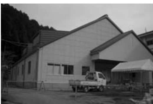
現在建設中の学校給食センター
