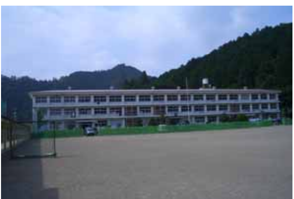
郡南中大規模改修状況
