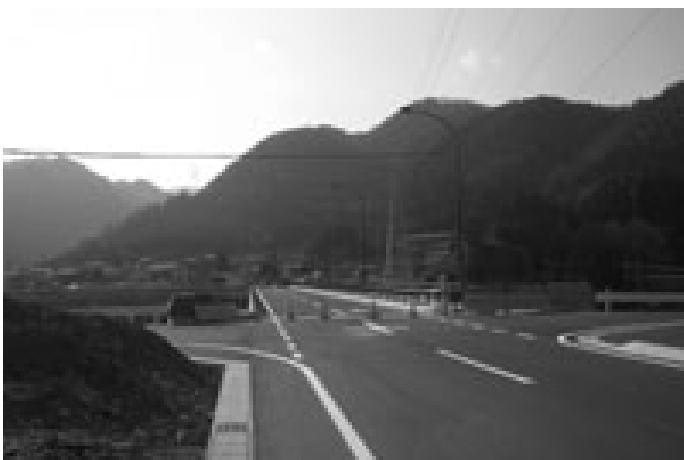
竣工間近の新吉田橋
