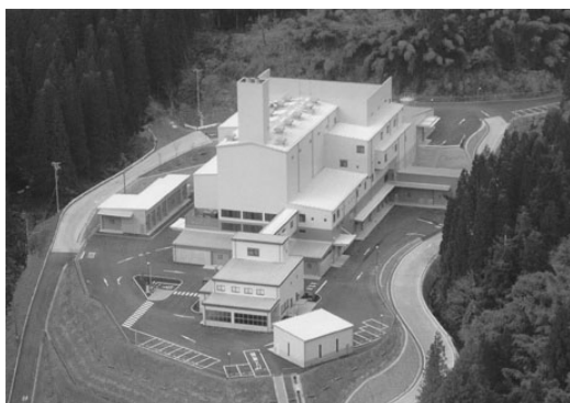
完成した郡上クリーンセンター
