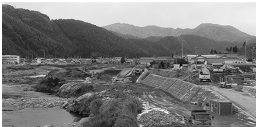
【新吉田橋上流長良川河川改修状況】
